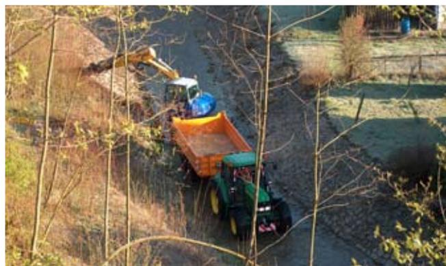
Die Anlandungen im Bachbett und der Bewuchs der Uferböschung werden mit dem Bagger entfernt.
